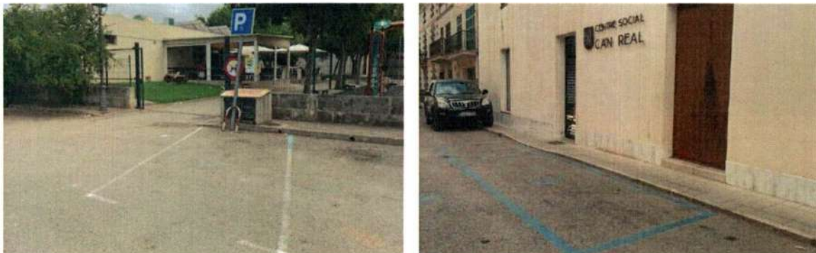
Reserva de places per a PMR al poliesportiu (esquerra) i al Centre Social Ca'n Real (dreta).
